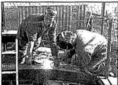
Michel Delalande est plutôt satisfait de ses « apprentis ». Après quelques mois passés sur le chantier ils sont désormais autonomes.
