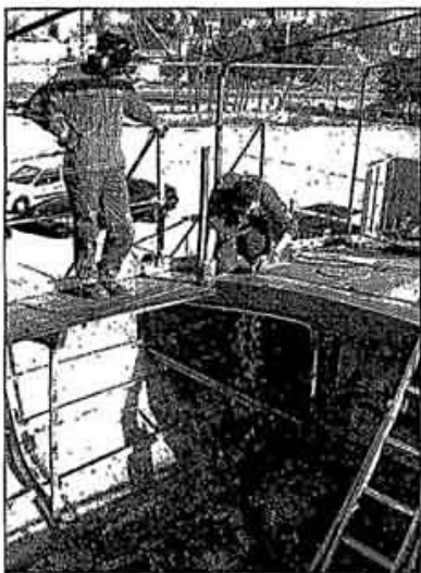
Actuellement une quinzaine de personnes tourne régulièrement sur ce chantier de réparation navale. Leur but : rénover « La Belle Aventure ».
